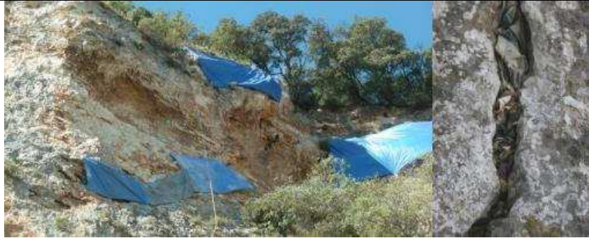
Figure 87 : Exemple de défavorabilisation de fissures sur une falaise (source : NATURALIA)
