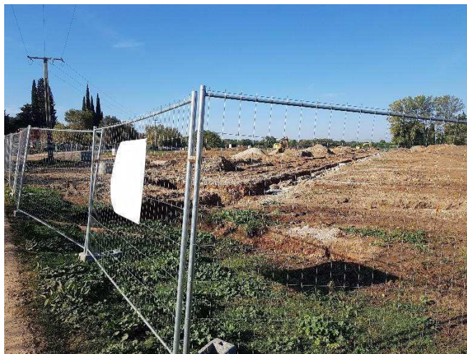
Figure 39 : Clôture de chantier (Source : H. MAIGRE lors d'un suivi de chantier pour Ecotonia)
